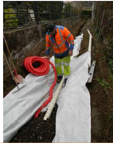
Travaux sur la venelle pour améliorer le cheminement des piétons (décaissement, tranchée, drain et gaine éclairage public, grave compactée)
