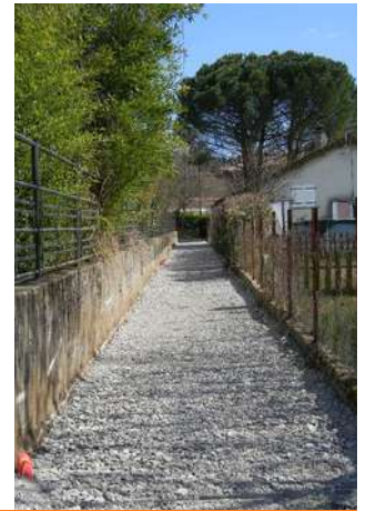
Travaux sur la venelle pour améliorer le cheminement des piétons (décaissement, tranchée, drain et gaine éclairage public, grave compactée)
