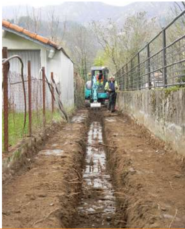
Travaux sur la venelle pour améliorer le cheminement des piétons (décaissement, tranchée, drain et gaine éclairage public, grave compactée)
