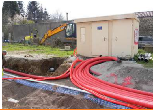
Gaines électriques (20 000V, 380V, éclairage public, télécom) pour l'enfouissement de la RD5 et la création de logements et d'une micro-crèche
