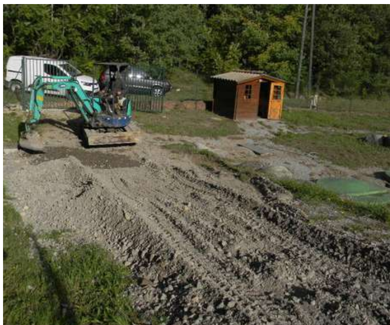
D'importants travaux de remise en état des infrastructures après les intempéries
