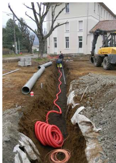
Tranchée eau pluviale et éclairage
