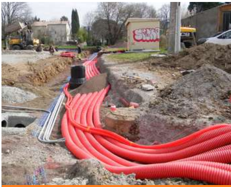
Gaines électriques (20 000V, 380V, éclairage public, télécom) pour l'enfouissement de la RD5 et la création de logements et d'une micro-crèche
