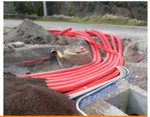
Gaines électriques (20 000V, 380V, éclairage public, télécom) pour l'enfouissement de la RD5 et la création de logements et d'une micro-crèche
