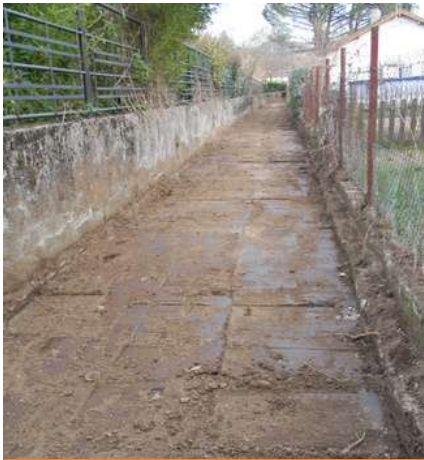
Travaux sur la venelle pour améliorer le cheminement des piétons (décaissement, tranchée, drain et gaine éclairage public, grave compactée)
