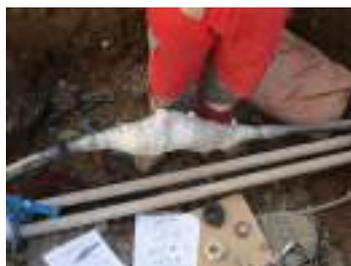
Sensibles aussi sont les raccordements des câbles triphasés 20kV en pleine tranchée qui nécessitent une succession d'opérations rigoureuses.
