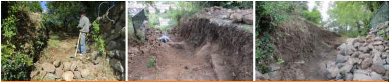
Démontage du vieux mur de soutènement du passage de l'ancienne calade et creusement du talus
