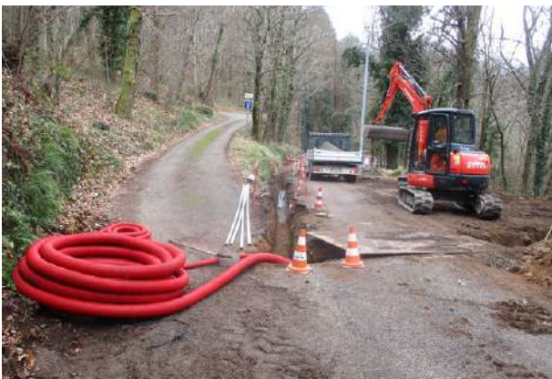
Les travaux d'enfouissement des réseaux secs à la Turbine
