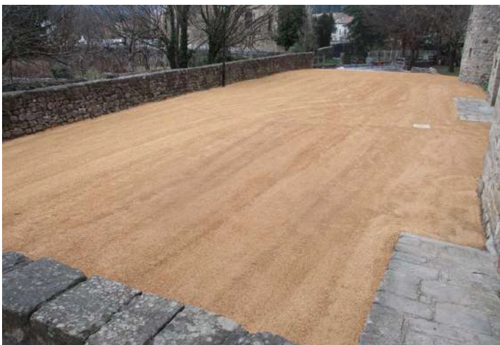
L'aménagement du parking à l'arrière du Château de Castrevieille
