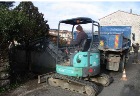
La pose de compteurs d'eau de sectorisation
